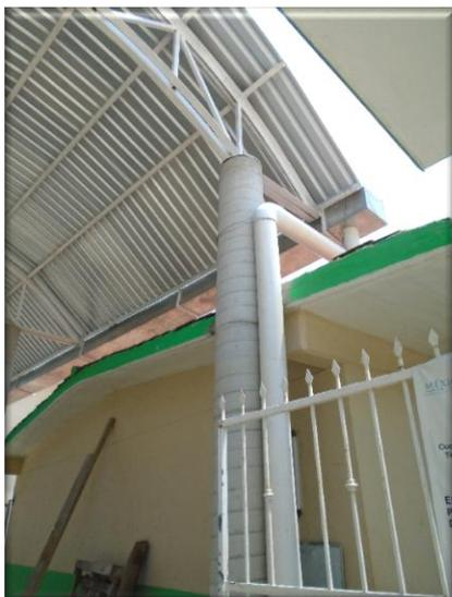
Tubería de PVC ara captación de agua pluvial **ANTES** de su conexión al drenaje
