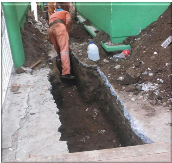
Vista de los trabajos de apertura de Ceba **ANTES** de su conexión al Drenaje Pluvial
