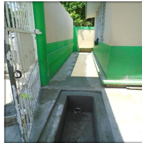
Registro final de captación de aguas de escurrimiento y conexión a la línea de drenaje pluvial en su fase **FINAL**
