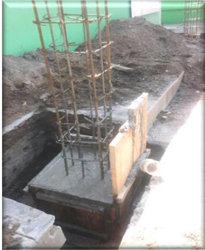
Colado de concreto de zapata **ANTES** del colado de la columna
