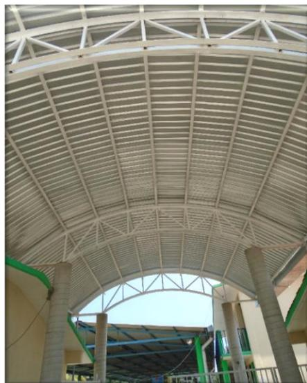
Colocación de Techumbre con lamina Galvanizada **DURANTE** las obras
