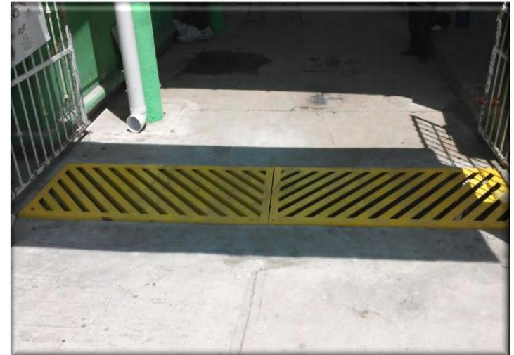
Vista de rejilla en zona de captación de agua **DESPUES** de su colocación, sobre el drenaje de agua pluvial.
